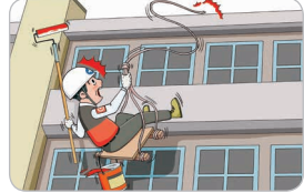
달비계를 사용하여 건물 외벽 청소에 구명줄 미설치
